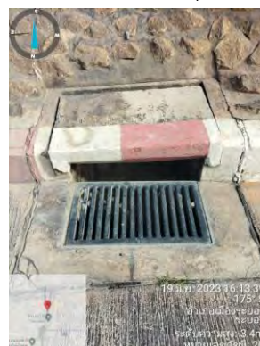
ภาพที่ 2.1-11 ตะแกรงดักเศษวัสดุก่อสร้าง
