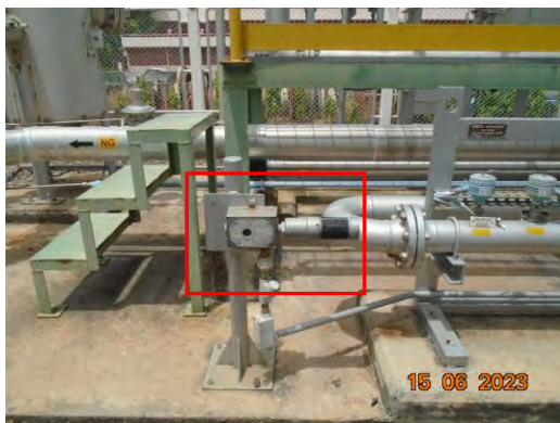
ภาพที่ 2.2-55 อุปกรณ์ตรวจจับการรั่วไหลของ NG ที่เชื่อมต่อกับระบบควบคุมการทำงานของกังหันก๊าซ และหม้อไอน้ำ
