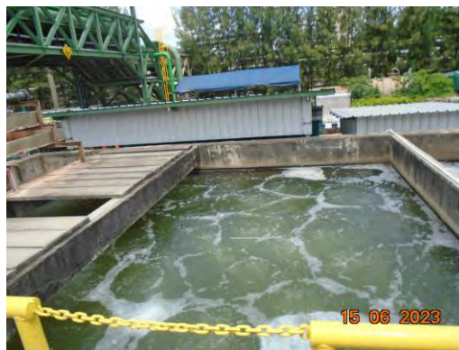
ภาพที่ 2.2-14 บ่อพักน้ำทิ้ง บ่อที่ 1 (Holding Pond No. 1)
