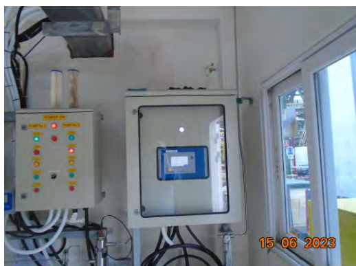
ภาพที่ 2.2-15 เครื่องมือตรวจวัดซีไอดีแบบต่อเนื่อง (COD Online)
