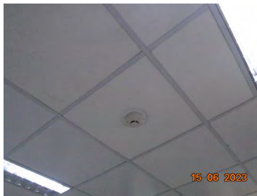
ภาพที่ 2.2-50 Smoke Detection
