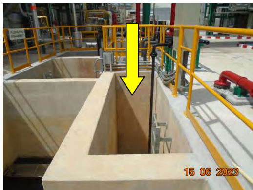
ภาพที่ 2.2-19 Oil Separator Tank ขนาดในการบำบัด 14 ลูกบาศก์เมตร
