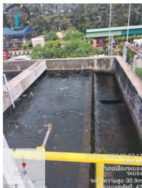
ภาพที่ 2.1-20 บ่อปรับสภาพน้ำเสีย (Neutralization)
