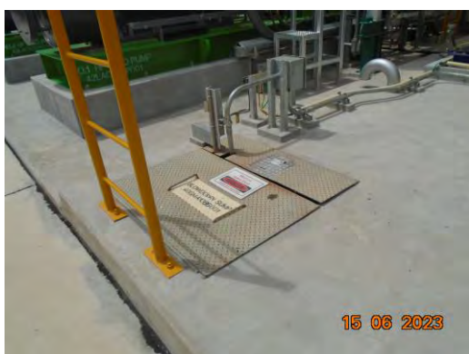
ภาพที่ 2.2-17 ถังดักไขมัน (Oil Separator Tank) บริเวณหม้อแปลงกระแสไฟฟ้า
