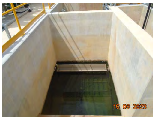
ภาพที่ 2.2-18 Oil Separator Tank ขนาดในการ บำบัด 40 ลูกบาศก์เมตร
