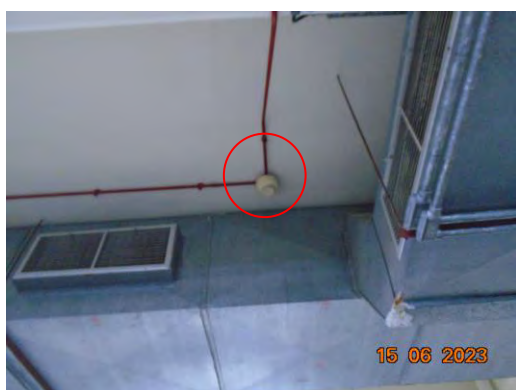
ภาพที่ 2.2-51 Heat Detection
