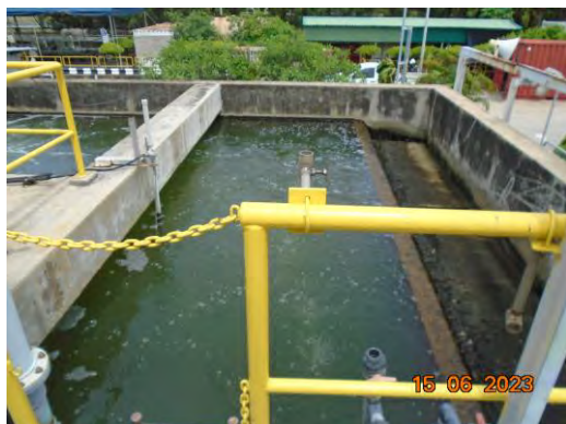
ภาพที่ 2.2-13 บ่อปรับสภาพน้ำเสีย (Neutralization Pond)
