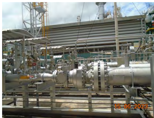
ภาพที่ 2.2-56 วาล์วควบคุม 2 นิ้ว ในระบบก๊าซ NG
