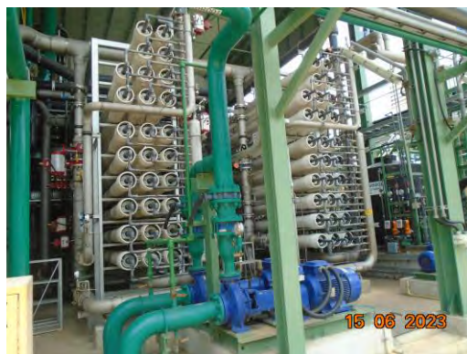
ภาพที่ 2.2-12 ระบบผลิตน้ำปราศจากแร่ธาตุ
