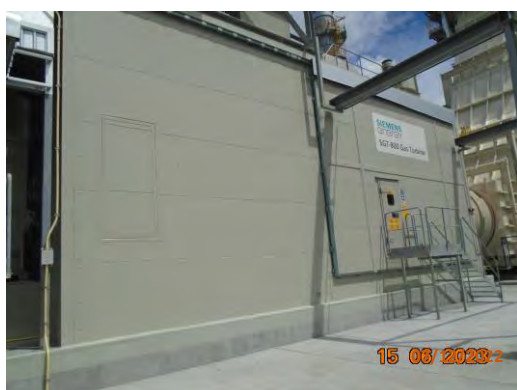
ภาพที่ 2.2-24 อุปกรณ์ลดเสียง (Enclosure)
