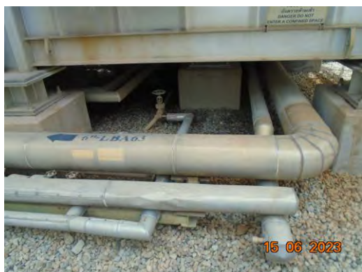
ภาพที่ 2.2-9 Steam Injection System
